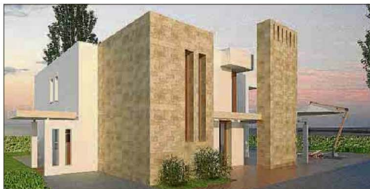
Cara norte de la vivienda, que es más pétreo para aislar el viento frío del invierno. LEVANTE-EMV
