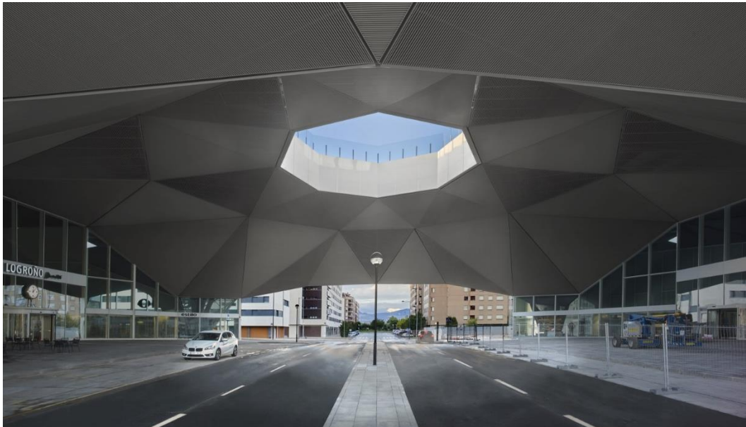
Imagen 5: Cúpula de conexión de las dos estaciones. ©Jesús Rocandio (2020)
